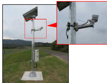
簡易型河川監視カメラ
