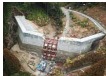
工事現場風景(砂防ダム) (薩摩川内市入来町大馬越)
