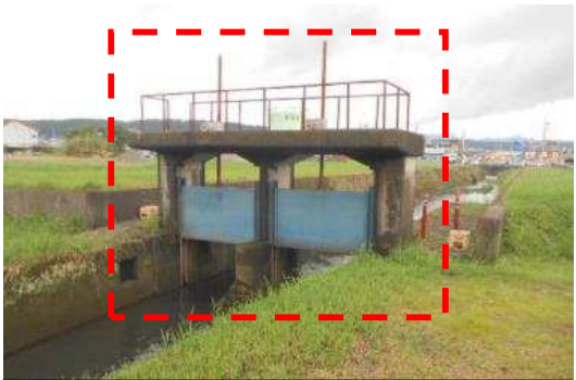
原田井堰の撤去 (R5)
