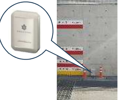
浸水センサ設置
