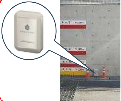
浸水センサ設置
