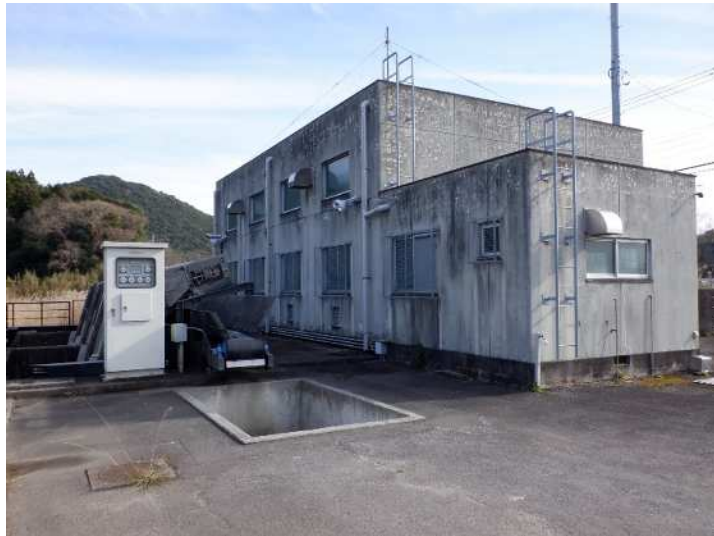
湯島排水機場
