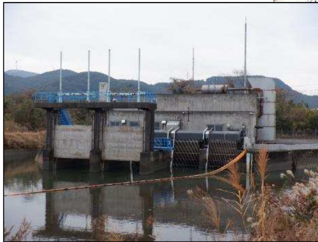
湯島排水機場
