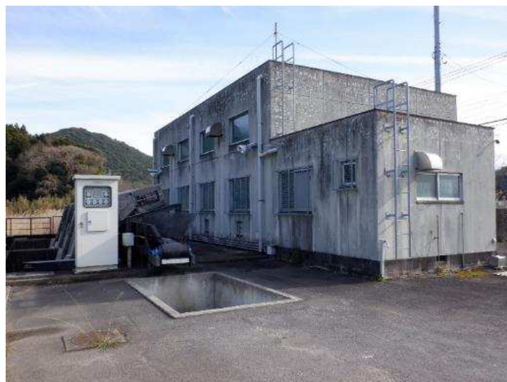
網津排水機場
