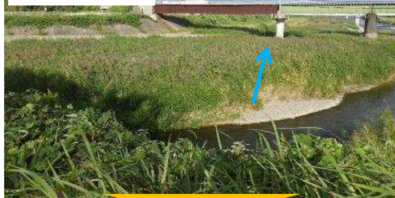
【施工前】米之津川
