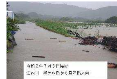
江内川 令和2年7月と令和3年8月の被災状況
