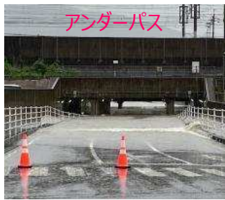
排水ポンプ施設付近
