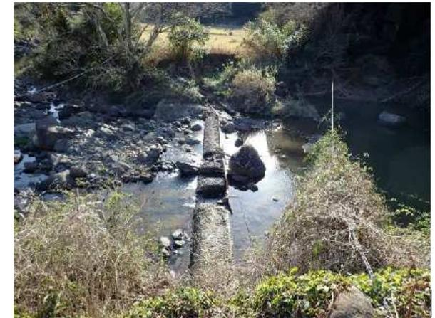
固定堰により取水を行っているが堰天端の摩耗により用水路への導水に支障をきたしているため堰改修いぜきの嵩上げを検討中。
