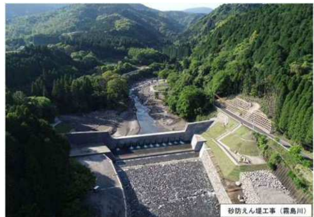
砂防えん堤工事（霧島川）
