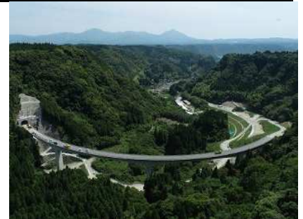
国道504号西光寺拡幅（施工中）
