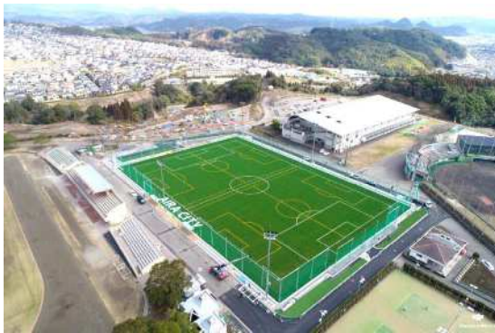
始良フットボールセンター
