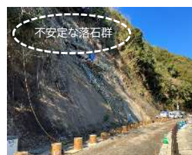
被災状況(法面崩壊)
