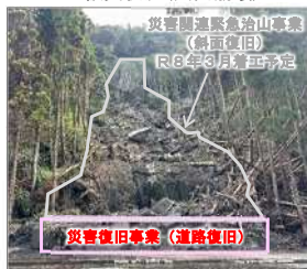
被災状況(法面崩壊)
