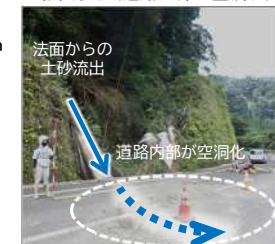
被災状況(道路内部の空洞化)
