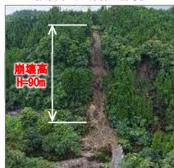
被害状況(斜面崩壊)
