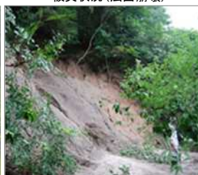
被災状況(法面崩壊)
