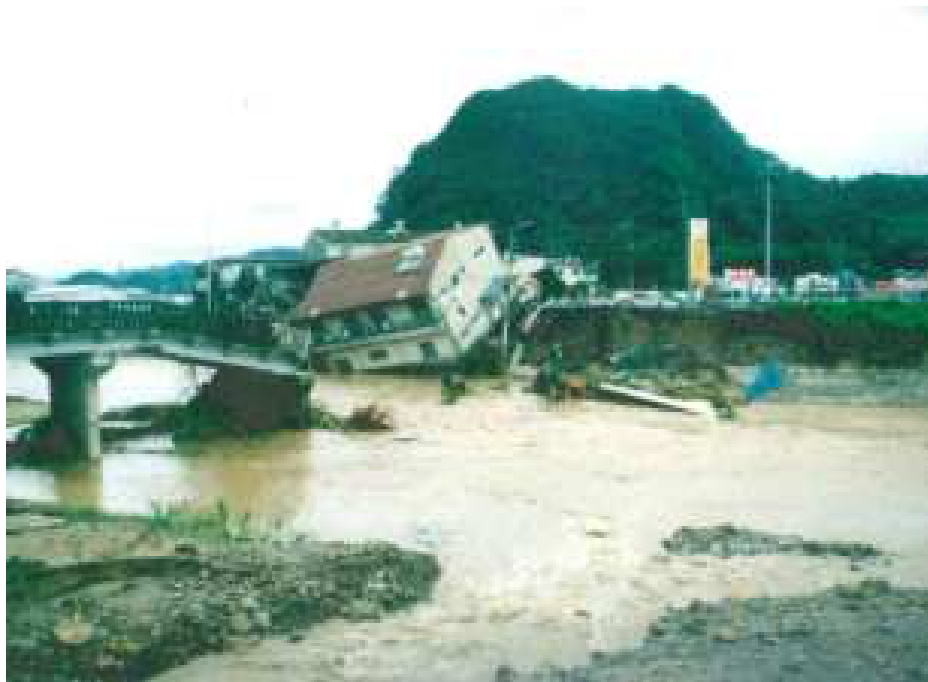
平成5年8月1日の集中豪雨 思川 城瀬橋
