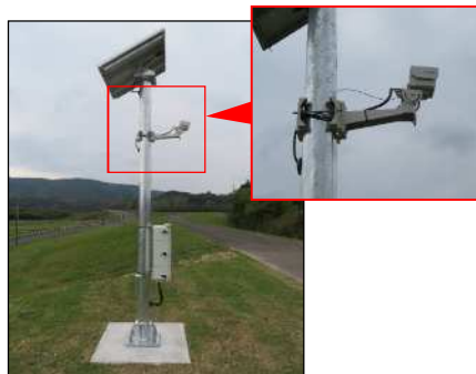
簡易型河川監視カメラ
