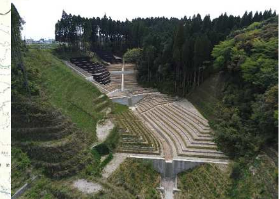
山地災害の復旧(完成) 溪間・山腹工
