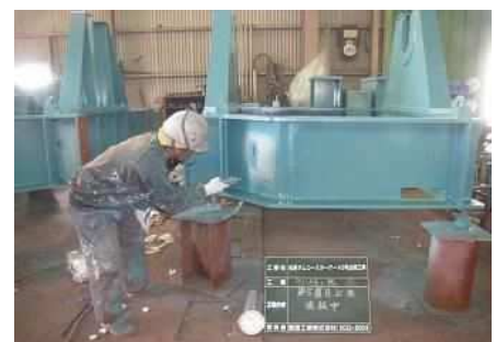
塗装による機械設備の補修
