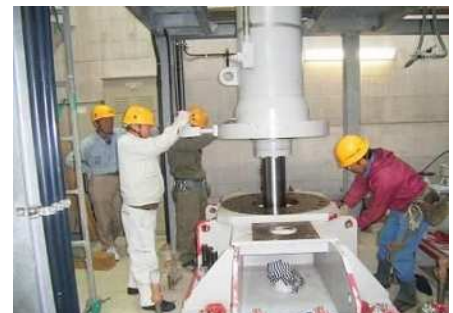
分解・部品交換による機械設備の修繕・更新
