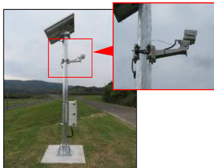
簡易型河川監視カメラ
