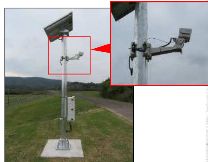
簡易型河川監視カメラ
