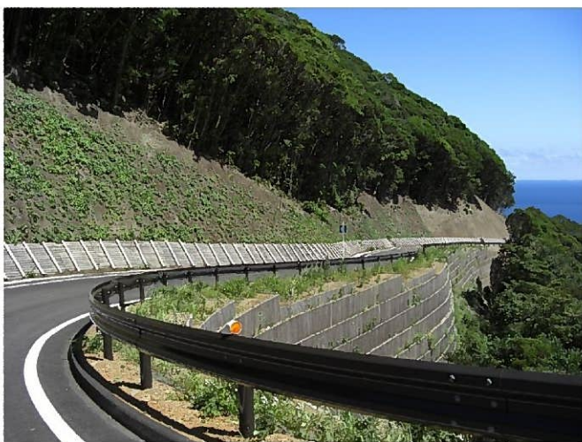
屋久島南部線3工区 (屋久島町湯泊地内)
