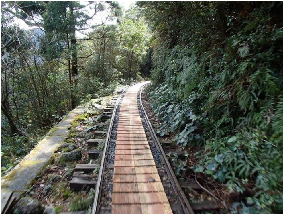
安房森林軌道内（荒川登山口～小杉谷橋入口）に踏み板を設置 （平成29年度完成）
