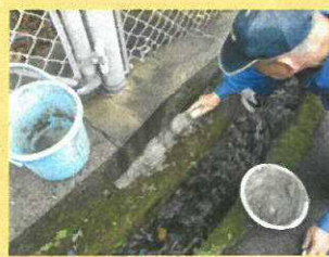
側溝の補修
