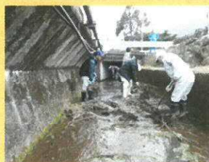
水路に堆積したゴミや土砂の除去
