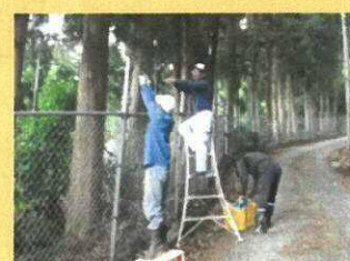
獣害防止柵の補修
