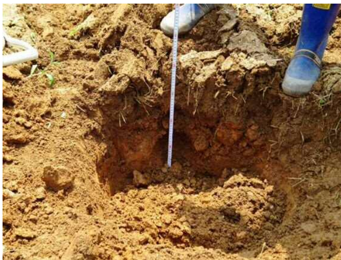
施工後の破砕深さ（深さ40cm）
