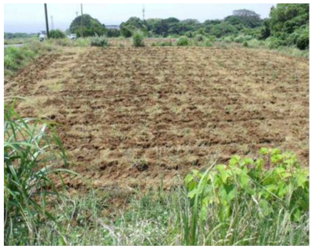
施工後の状況
