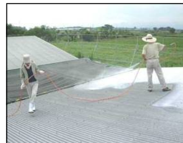
写真 屋根への石灰塗布
