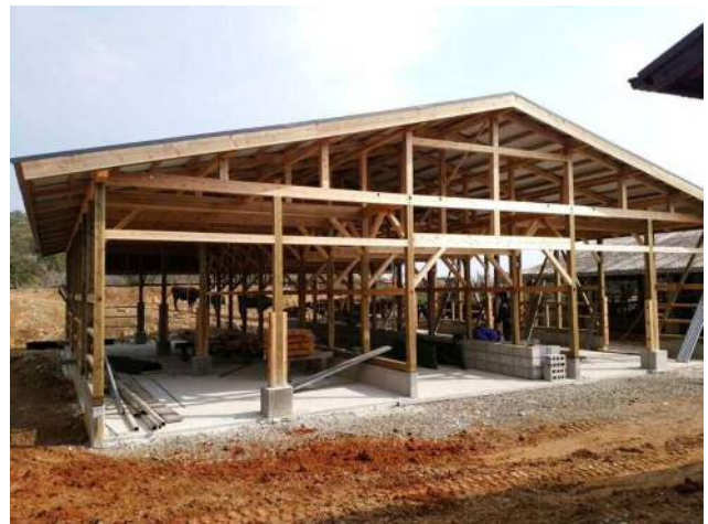
<建設中の分娩舎>
