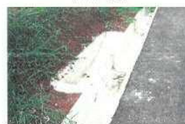
国道和瀬バイパス工事実施例(大島支庁土木課)
