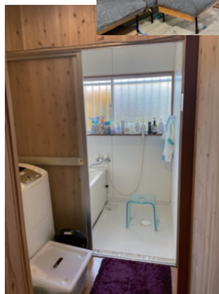
▲倉庫部分を脱衣所と浴室に改修（龍郷町）
