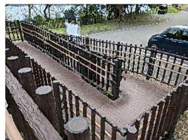
スロープの勾配が緩く、上りやすさに配慮されているため、通路の延長が長くなっている。手すりの高さが車いす利用者の目線の高さに近く、手すりの隙間から風景を見ることになってしまう。
