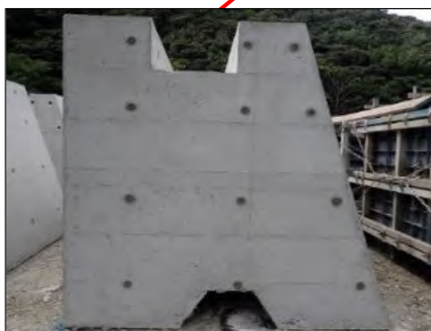
護岸ブロック
