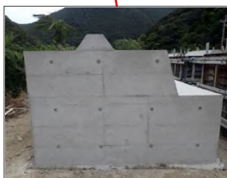
護岸ブロック
