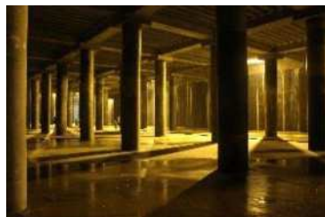
大規模地下貯留施設(下水道)
