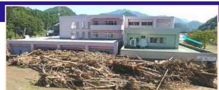
平成28年台風10号により、岩手県のと配慮者利用施設では利用者9名の全員が死亡。
