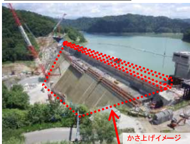
ダム建設・ダム再生
