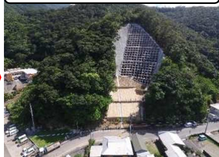
治山施設の整備（山腹工）
