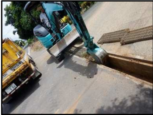
水路の土砂除去
