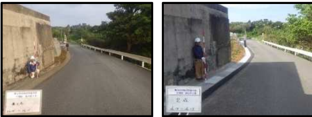
水路の改修工事
