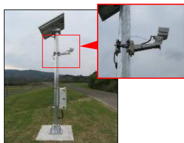
簡易型河川監視カメラ
