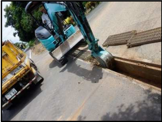
・水路の土砂除去を直営施工で実施
