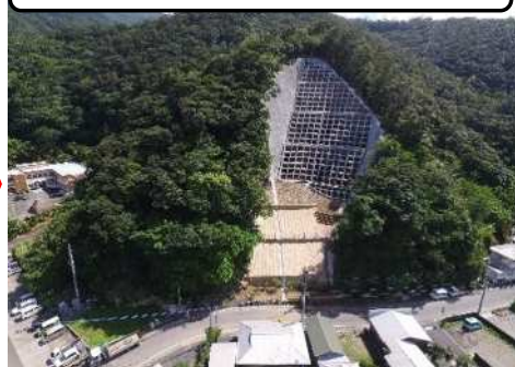
治山施設の整備（山腹工）
