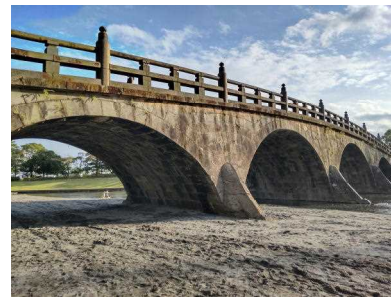
【溶結凝灰岩で作られた石橋】
