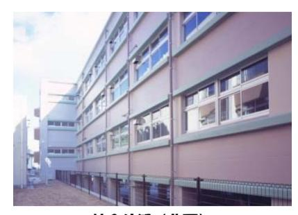
校舎外観(北面) 外装に木目化粧型枠コンクリートを使用し 木のぬくもりを感じられる
