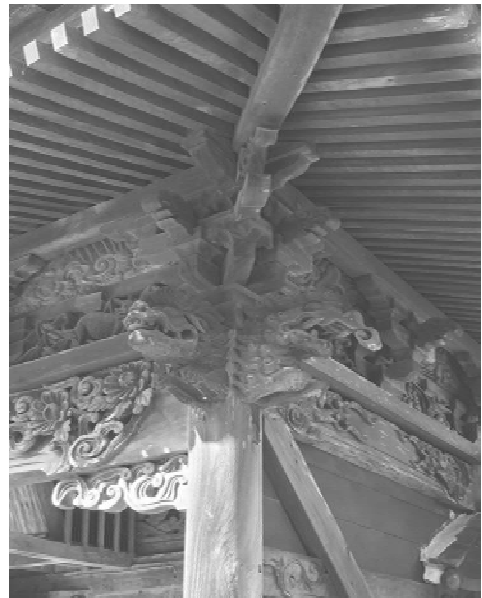
写真5 背面右柱上の木鼻(獅子摸)と組物
