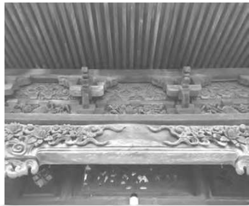
写真4 下から頭貫(虹梁), 台輪, 斗拱(出組)
