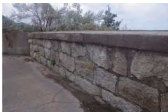
屋久島灯台石塀
