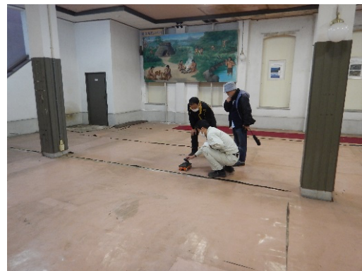
写真4-2 床下の探査状況 (令和3年12月16日非破壊調査)
