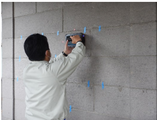
写真4-1 石壁の探査状況 (令和3年12月16日非破壊調査)
