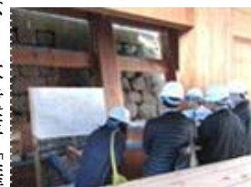
御楼門建設現場の見学
