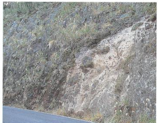
野間岳山麓でみられる溶岩と凝灰角礫岩との境界部（境目から水がしみ出している）
