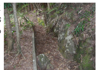
写真4 発電用水路跡
