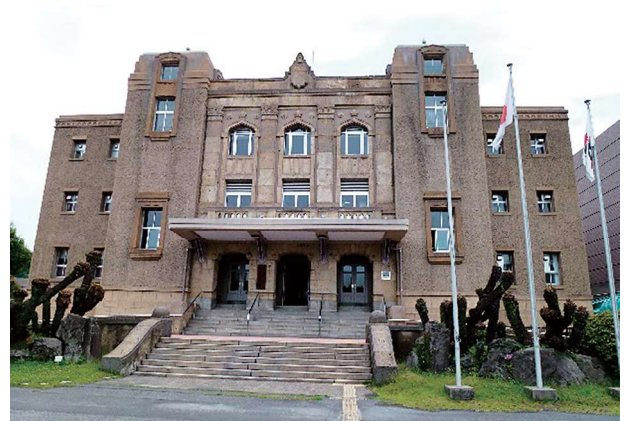
図7 溶結凝灰岩（加治木石）で造られている鹿児島市中央公民館
