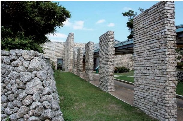
図5 サンゴ石灰岩の石壁と石垣（奄美パーク）
