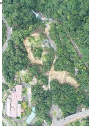
霧島市牧園町 9/18 がけ崩れ
