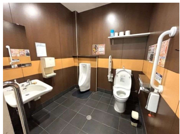
一般トイレと共用の車いす対応トイレ
