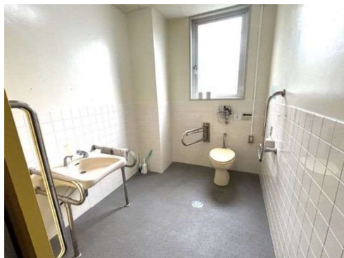
車いす対応トイレ
