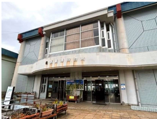
亀徳新港待合所
