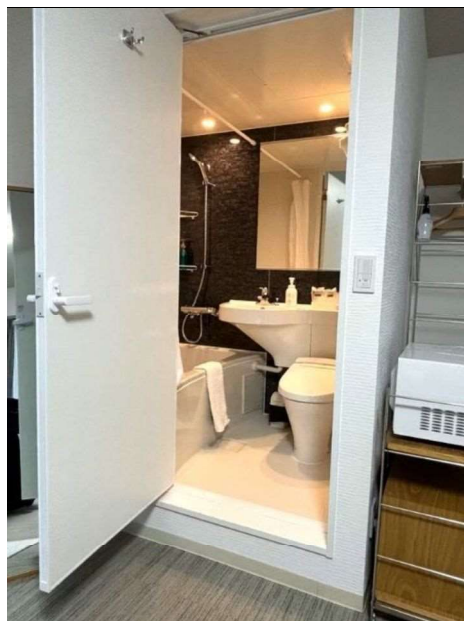
バス・トイレは段差があるが間口は広い
