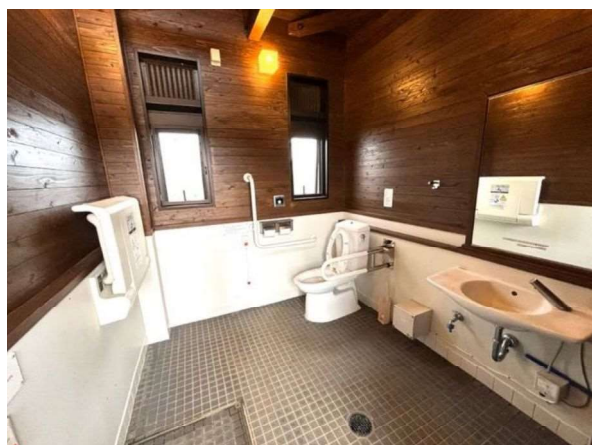
車いす対応トイレ
