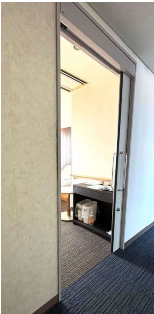
客室入口は引き戸
