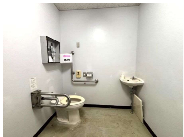
車いす対応トイレ内部
