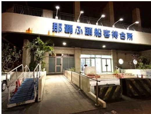
那覇港ターミナルビルの那覇埠頭側入口
