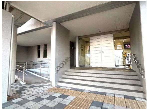
建物玄関は階段だが、スロープも併設されている
